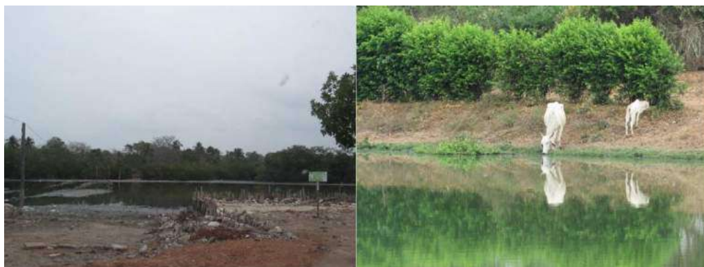
Figura 1-11. Lagunas de Oxidación en San Onofre con a) presencia de residuos sólidos y b) ganado vacuno en sus alrededores. Fotos: Ostin Garcés.
