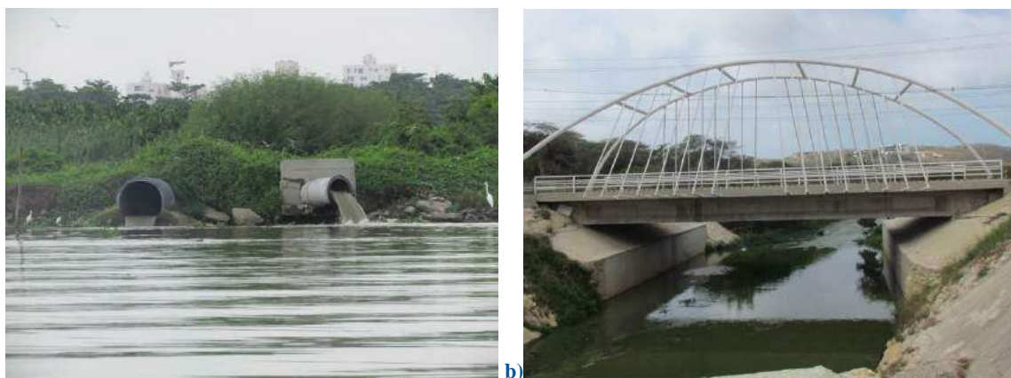
Figura 6-4. Vertimientos de aguas residuales en la zona de la estación frente a Base Naval (a), foto: Paola Obando en agosto 2015. Aguas negras que circular en el arroyo León (b), fotos: Ostín Garcés, febrero 2016.
