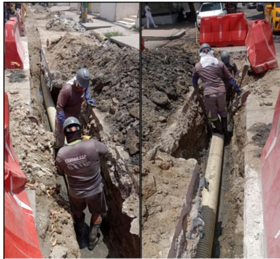
Imagen 1 y 2. Obras de Trabajos Sector Cehoca.
