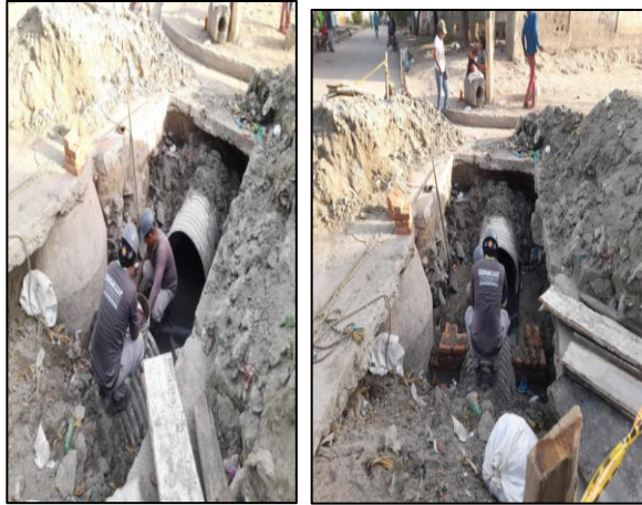
Imagen 3 y 4. Obras de Trabajos Sector Pescaito.
