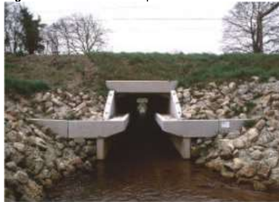
Figura 40: Box culvert con pasarelas a ambos lados.
