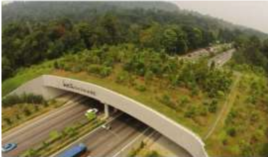
Figura 19: Ecoducto “Ecolink”, en Singapur, conecta dos áreas protegidas (Bukit Timah Nature Reserve, y Central Catchment Nature Reserve) pasando sobre la autopista Bikit Timah. Tiene una longitud de 62m y un ancho de 50m en el punto más estrecho
