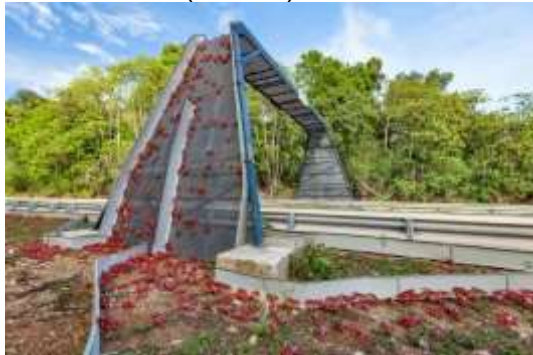
Figura 21: Ecoducto para paso de la migración periódica de cangrejos entre el bosque y el mar, en Christmas Island (Australia)
