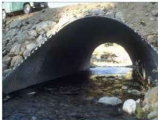
Figura 59: Uso de una alcantarilla de sección abierta, para minimizar la intervención del cauce.
