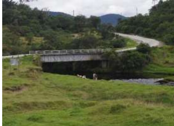
Figura 60: Puente sobre el río Cauca, en Paletará, Cauca, con el cauce libre de intervención.
