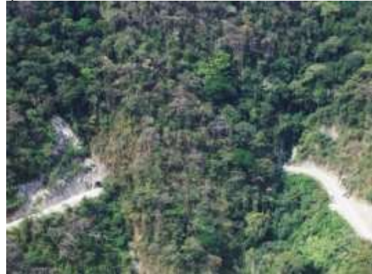
Figura 20: Túnel vial generando un paso de fauna superior con cobertura arbórea continua.
