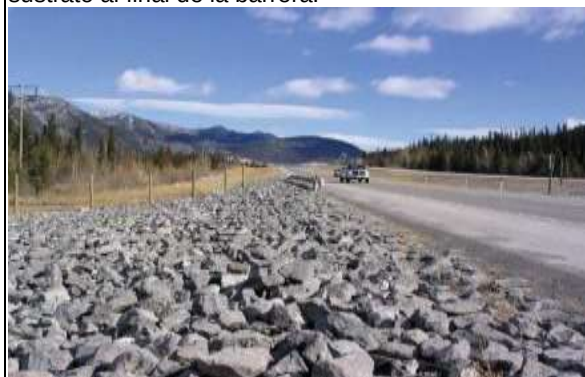
Figura 71: Lecho de piedras utilizado como cambio de sustrato al final de la barrera.
